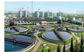
1999年9月29日收购高碑店污水处理厂一期工程，当时该厂是亚洲第一大污水处理厂
